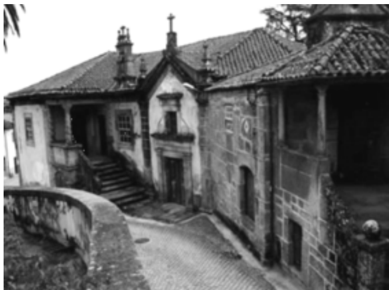
Figura 1 – Um solar genuíno , em granito e com pedra à mostra
